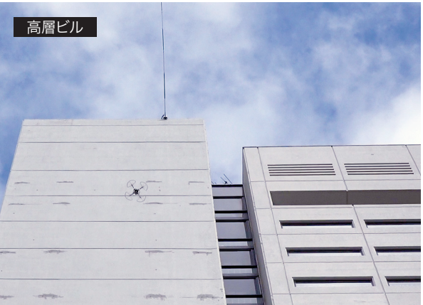
【中野サンプラザ】 高層建築物における壁面状況調査に使用 ▶ 2020年3月 ▶ 高さ：92m
