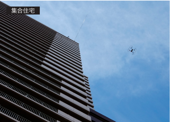
【超高層集合住宅】 超高層建物外壁点検調査 ▶ 2022年1月 ▶ 高さ：102m
